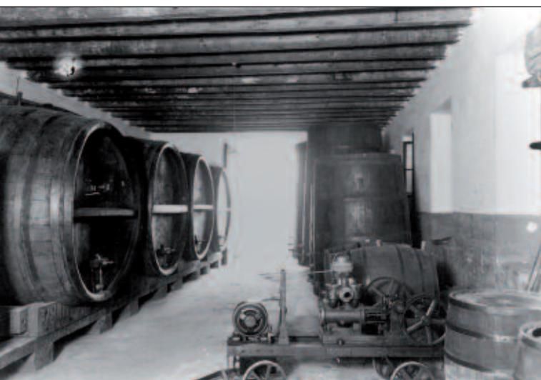
La cantina dell'istituto con i tini per l'ammostamento e la fermentazione alcolica, in primo piano una pompa per l'esecuzione dei travasi.
